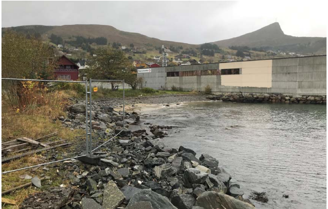
Bygningsstengsel mot vest. Foto Nordplan AS.
