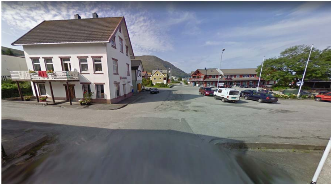
Biletet viser manglande samanbinding aust-vest, problem med kantstein og smale fortau langs bygningar. Kjelde google maps.
