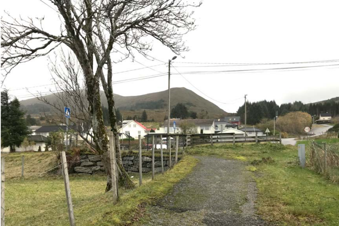
Biletet viser dagens gangveg forbi Triveli, og kryssingspunktet med fylkesvegen. Dårlig lyssetting i krysset, og manglande sykkelsluser. I dag er gjerdet som skal fungere som sperre, i dårleg stand og bidreg til sikt-hindring. Foto Nordplan AS.
